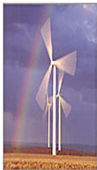
Central Eoeléctrica de 160.00 Mw
