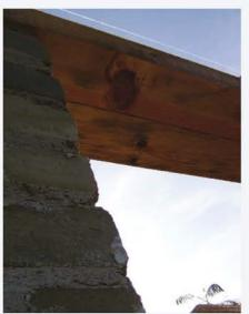
· LOSA DE AZOTEA.- La losa de azotea es a base de vigas de 2" x 4", colocadas a cada 61 cm, dichas vigas se fijaron a las cadenas de cerramiento por medio de taquetes de expansión de 5/16" y placas de 2" x 2" x \_" con cuatro tornillos de 3", posteriormente se colocaron hojas de triplay de 1.22 x 2.44 x 0.019 ancladas a las vigas con tornillos de 2 ", por último se le aplicó una mano de emulsión asfáltica como protección adicional, cartón asfáltico e impermeabilizante prefabricado integral.
