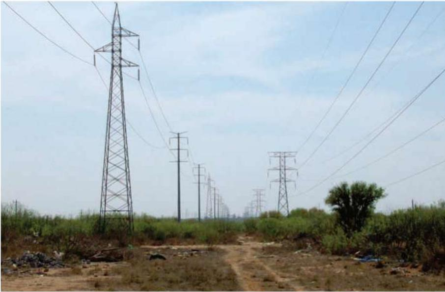
La línea de transmisión tendrá una longitud de 13 km con un ancho de vía de 18 m (46.8 hectáreas).
